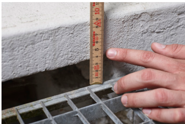
Innenmass zwischen Gitterrost und Wandausschnitt messen und 25mm dazurechnen.
