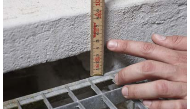
Innenmass zwischen Gitterrost und Wandausschnitt messen und 25mm dazurechnen.
